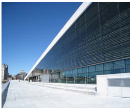
Sydfasaden med solceller
