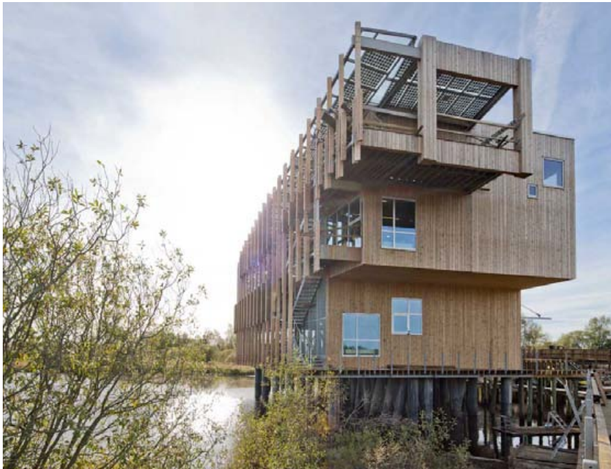
Solcellerna integrerade i taket fyller flera funktioner genom att skydda mot sol och regn samtidigt som de producerar el. Ritat av White. Foto Kasper Dudzik.
